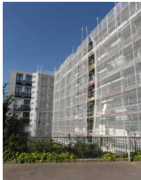
Dans cet immeuble du Mont-Valérien, des travaux d'isolation thermique ont été réalisés avec l'aide de Nanterre Habitat Plus.
